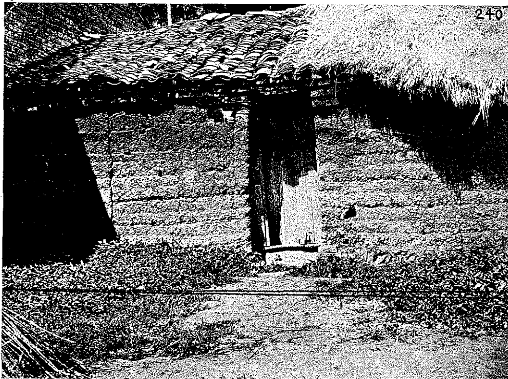
FIG. 436. A CHINESE HOUSE BUILT OF PISÉ DE TERRE.
