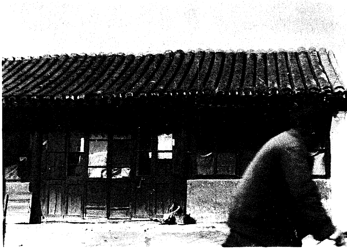
Abb. 3.10 Tonziegeldach in China (ähnlich wie Mönch- und Nonnen-Deckung) Fig. 3.10 Clay tile roof in China (similar to Spanish type)
