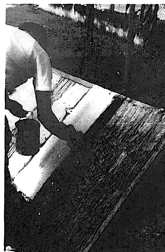
Abb. 6.24 Teile der Pajón-Deckung, mit einem wasserabweisenden Conservex-Anstrich versehen. Fig. 6.24 Sections of the pajón covering received a coat of Conservex for waterproofing.
