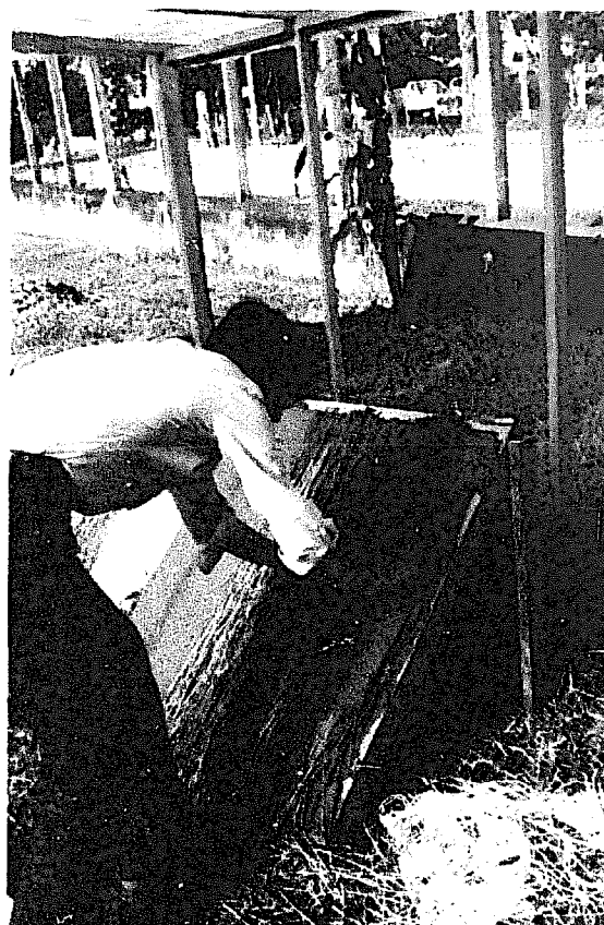
Abb. 6.20 Mit dicker Erd-Kalk-Mischung getränktes Sisalsack-Material, die letzte Pajón-Lage überdeckend aufgeklebt, um dadurch den Pajón festzuhalten und nach dem Trocknen Verschiebungen zu verhindern.
