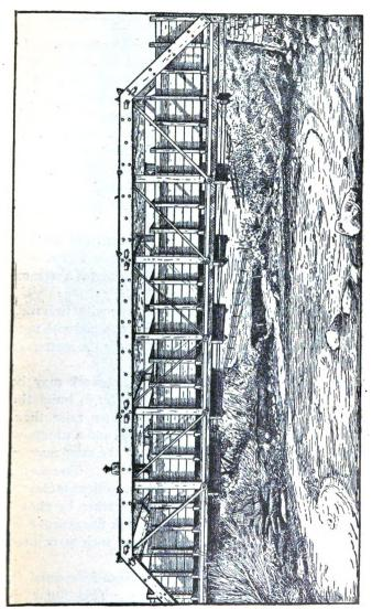
FIG. 31-TRUSS FLUME ACROSS A STREAM.
